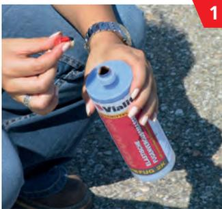
1 Verschlusskappe der Kartusche öffnen und die beigefügte Mischerspitze\* aufschrauben.
