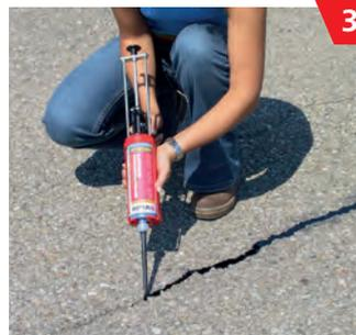
3 Den Inhalt der Kartusche zügig in die gereinigte Fuge einfüllen und vollständig aufbrauchen, da der Aushärtvorgang rasch beginnt.
