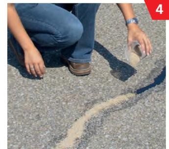
4 Die gefüllte Fuge kann mit einer Spachtel abgezogen und mit Splitt oder Sand abgestreut werden.
