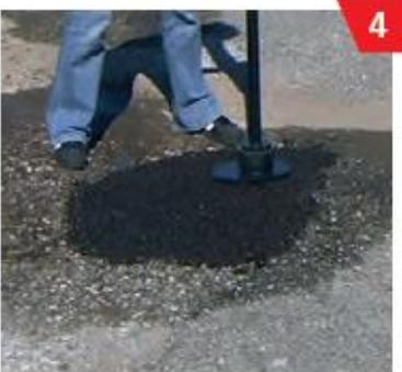
Mit Stampfer gut verdichten. Bei größeren Flächen wird eine Walze oder Rüttelplatte empfohlen.
