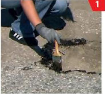
Für optimale Haftung wird die Vorbehandlung mit REAKTIV PRIMER / SPRÜHPRIMER empfohlen.
