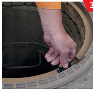
Einsetzen der ANTI-KLAPPER PADS (mind. 3 Stk.).
