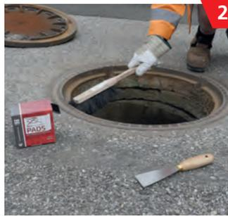
Reinigung des Falzes mittels Luft oder durch geeignete Werkzeuge.
