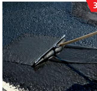
3 Nach dem Ausgießen unmittelbar mit einem geeigneten Gummischieber\* verteilen ...
