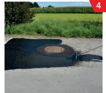
4 ... und **scharf** über das Korn abziehen, sodass die Asphaltstruktur noch sichtbar bleibt. Max. Trockenschichtdicke: ca. 0,5 mm.
