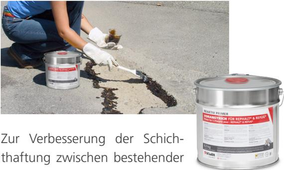
Zur Verbesserung der Schichthaftung zwischen bestehender Asphalt- oder Betonoberfläche und **REPHALT®** bzw. **REFUG®**.
