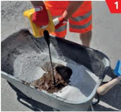
Der Sand wird in einem Mischbehältnis vorgelegt und anschließend die Bitumenemulsion zugegeben.
