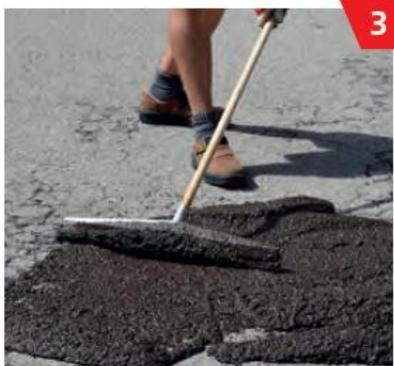
Mit einem Gummischieber oder einer Kelle rasch verteilen und auf Niveau bringen.
