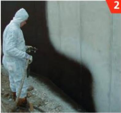
Das Mischen der zwei Komponenten erfolgt beim Auftragen durch die Mischpistole.
