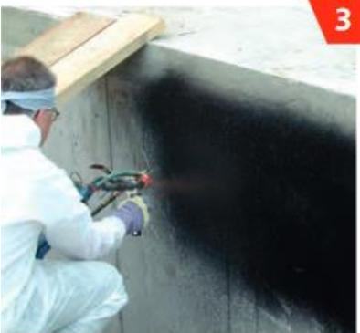
Das kreuzweise Aufspritzen von REBOND erfolgt in einer Schichtstärke von gesamt 4 mm.
