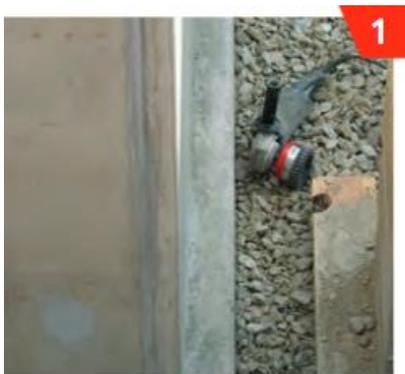
Grobreinigung und Nassabsaugung der Betonoberfläche.
