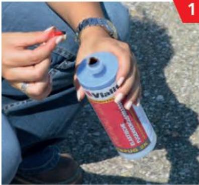
Verschlusskappe der Kartusche öffnen und die beigefügte Mischerspitze aufschrauben.
