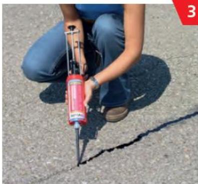
Den Inhalt der Kartusche zügig in die gereinigte Fuge einfüllen und vollständig aufbrauchen, da der Aushärtevorgang rasch beginnt.
