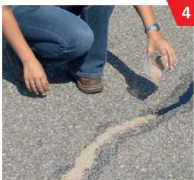
Die gefüllte Fuge kann mit einer Spachtel abgezogen und mit Splitt oder Sand abgestreut werden.
