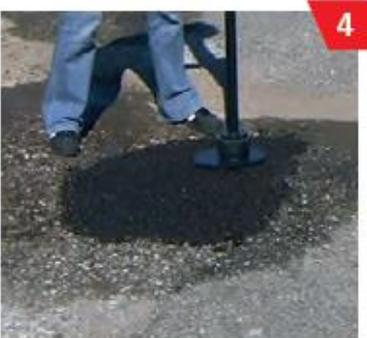
Bien compacter avec une dameuse. Pour les grandes surfaces, il est recommandé d'utiliser un rouleau ou une plaque vibrante.
