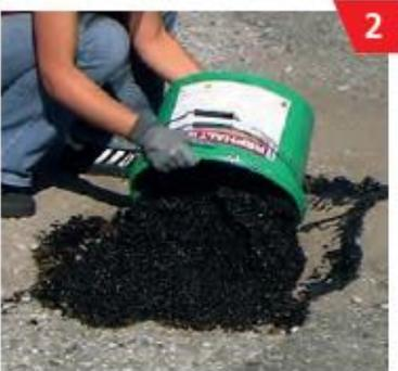
Mélanger REPHALT® de manière homogène avec environ 2 M% d'eau, puis l'appliquer sur la zone endommagée.
