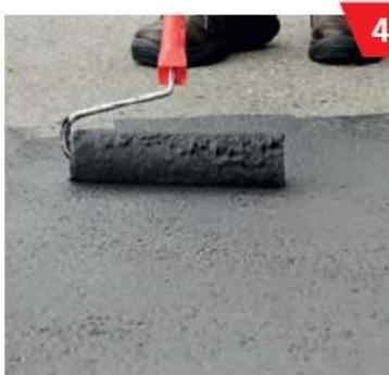
... und mit einem Versiegelungsroller porenfüllend in Bahnen abrollen.
