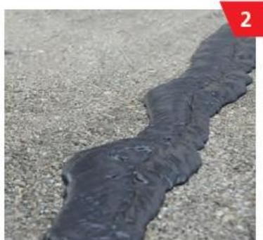
Die Fläche an den Rändern mit einem geeigneten Klebeband abkleben und danach STRADAFIX® portionsweise auf die Unterlage gießen.
