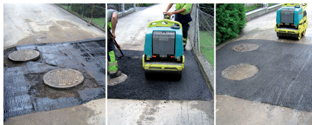
Zdjęcie: Viacore Asphalt © Vialit
